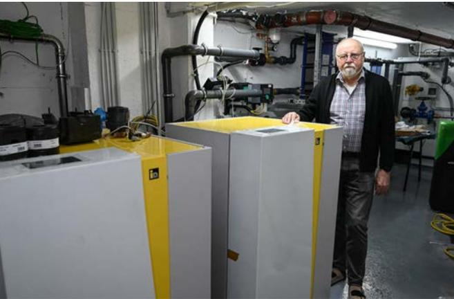
speicher und natürlich Wärmepumpen untergebracht. Ein gleichmäßiges Rauschen ist zu hören. Das ist das Grundwasser, das aus 18 Meter Tiefe in den Keller gepumpt wird – bis zu 23 Kubikmeter in der Stunde – und eine Temperatur von aktuell 14 Grad hat. „Die Wärmepumpen entziehen dem Grundwasser die Wärme, so dass es nur noch zehn Grad hat und wieder zurückgeleitet wird“, erklärt Peter Küsters (79), einer der Bewohner in der Wohn-
